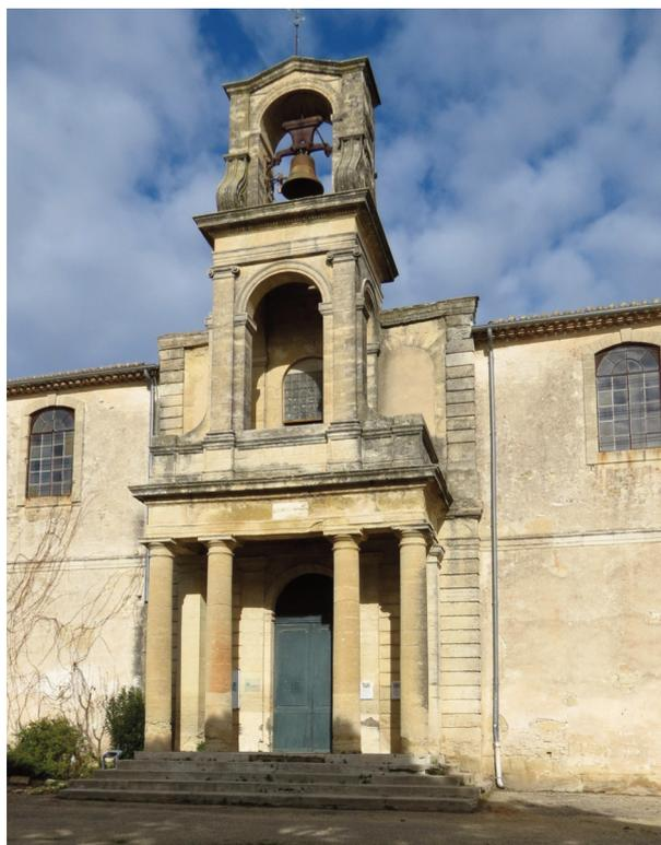
*Fig. 7. Gallargues-le-Montueux (Gard), le temple. ; le portail d'entrée à péristyle surmonté d'un portique portant le campanile. Le deuxième niveau, rapporté ultérieurement au projet initial occasionne des désordres et nécessite aujourd'hui d'être consolidé. V. Marill © Inventaire général Occitanie.*
